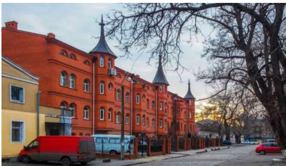
Рис.5. Малоповерхова високощільна зблокована забудова в історичному центрі м. Одеса
