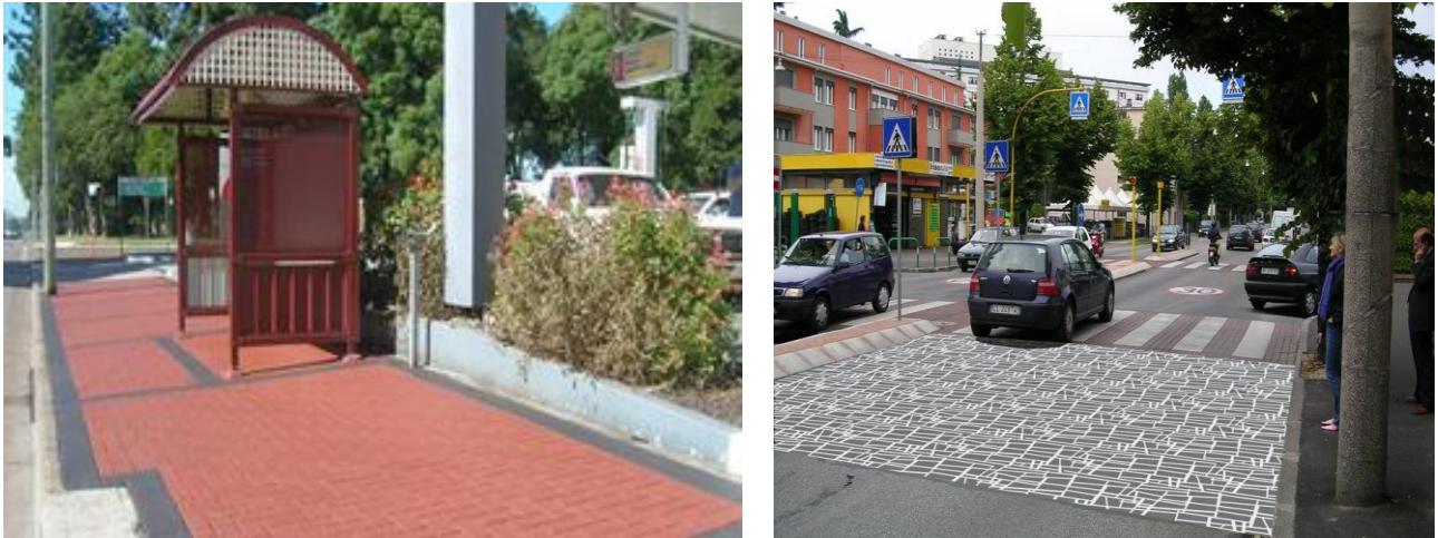
Рис. 2. Застосування декоративного покриття на автобусній зупинці і пішохідному переході
